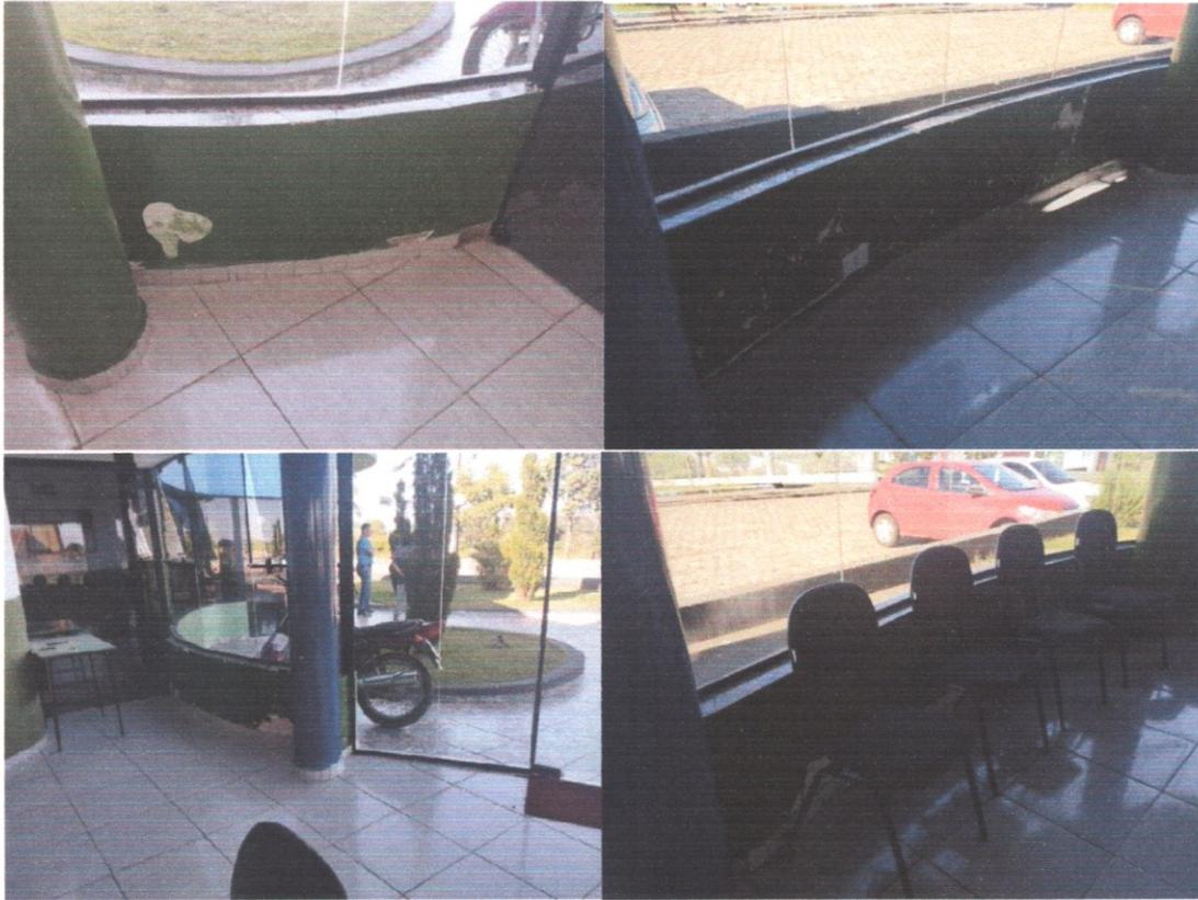
Figura 2 Remoção das patologias e aplicação da massa única para recebimento da pintura. Fonte: arquivo do autor, 2023.
